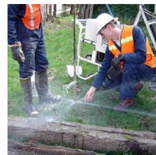
Figura 2 - Prova a bassa pressione con miscela in uscita da 4 ugelli ad apertura orizzontale
