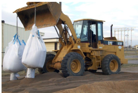
Figura 3. Mescolamento a secco di EHC (fornito in sacchi) e sabbia.
