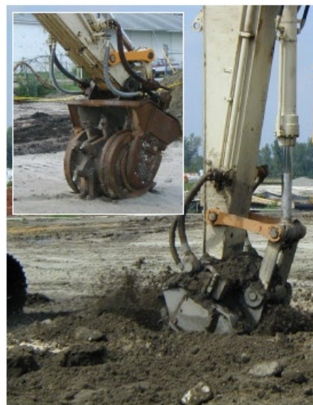
Figura 4. Soil mixing profondo mediante escavatore a braccio lungo. Foto per gentile concessione di Lang Tool
