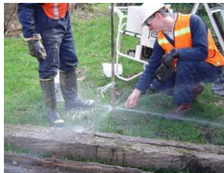
Figura 5. Punte da iniezione a direzione orizzontale. Dimostrazione con acqua a bassa pressione.
