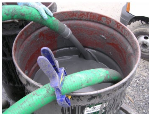
Figure 8. Preparazione della miscela di EHC attraverso sistema di ricircolo
